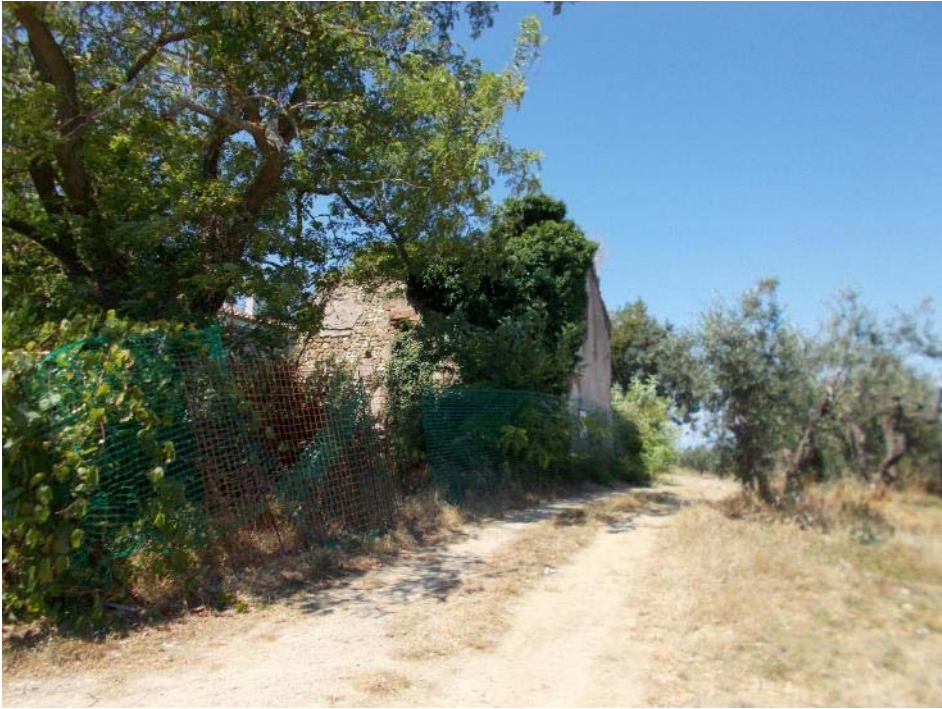
Foto effettuate durante il sopralluogo eseguito il 14/07/2020
